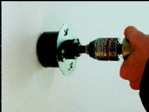
1) Vrtání otvoru do duté stěny pomocí vrtáku VDS 68.
