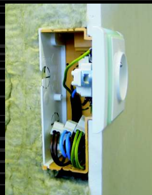
5) Příklad využití krabice (v řezu): např. vložení přepětové ochrany, svorkování pomocí bezšroubových svorek, použití svorkovnice S-66.
