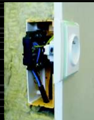
5) Příklad využití krabice (v řezu): např. vložení přepětové ochrany, svorkování pomocí bezšroubových svorek, použití svorkovnice S-66.
