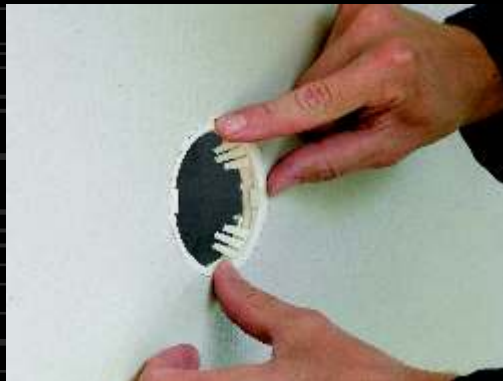
2) Vložení montážního kroužku do sádrokartonové stěny.
