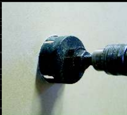
1) Vytvoření otvoru 73,5 mm do sádkartonu pomocí vrtáku VDS 68.
