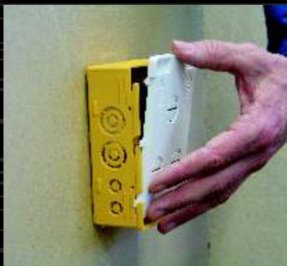
2) Vložení krabice KUH 1/L do připraveného otvoru. Uzavření krabice dnem.
