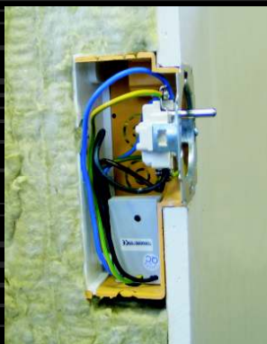
5) Příklad využití krabice (v řezu): např. vložení přepětové ochrany, svorkování pomocí bezšroubových svorek, použití svorkovnice S-66.
