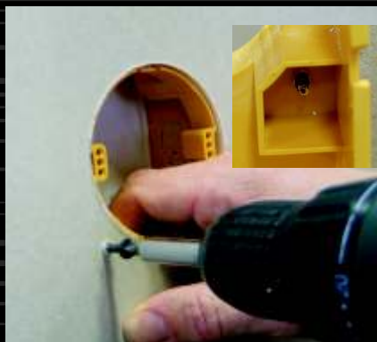
4) Upevnění krabice samořeznými vruty. Detail oddělení prostoru pro vruty.
